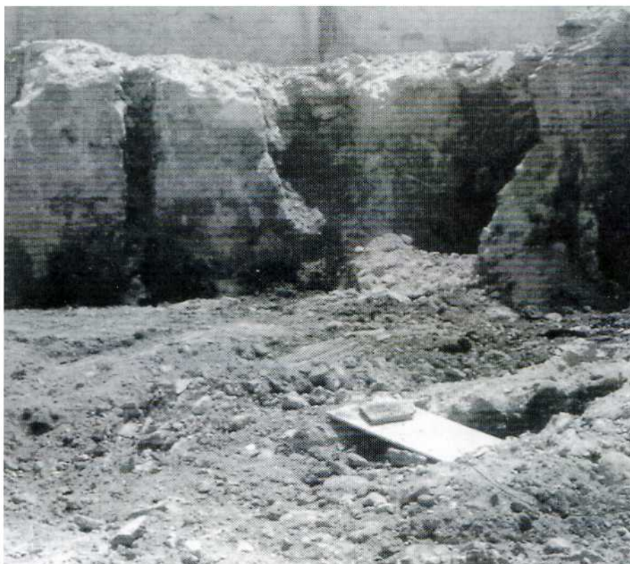
Fotografía nº 3. Derribo de los muros donde se aprecia la chimenea del hipocausto e impronta de la cámara inferior
