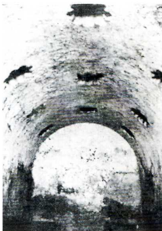
Fotografía nº 1. La Sala Fría abovedada con lucernas de los baños árabes.
