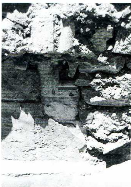
20. Esquina de la puerta in situ
