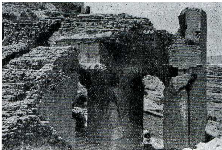
Fig. 6. a —El extremo izquierdo de la cávea, antes de las obras de restauración. (Mayo de 1955)
