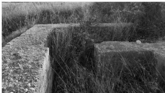
Entrada indirecta amb passadís en forma de L.
