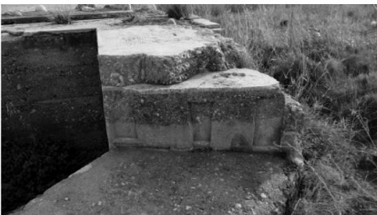
Marques laterals de la ubicació de taules de fusta en el mur de la tronera.
