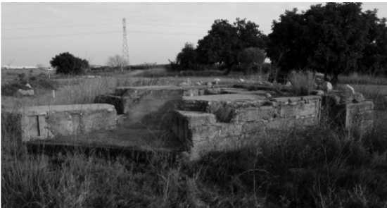
Niu de metrallador excavat des del costat oest ubicació al costat del passeig i vora el llit.
