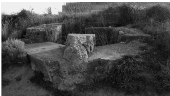
Niu de metrallador des del costat nord.
