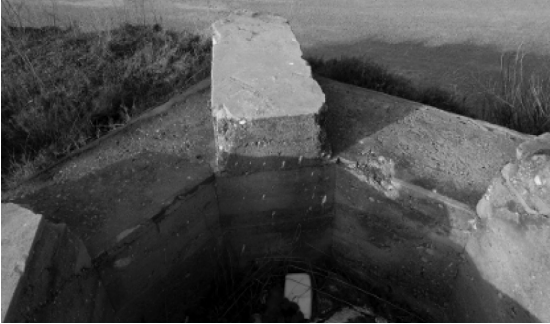
Troneres amb forma d'embut orientació nord-oest i nord-est.
