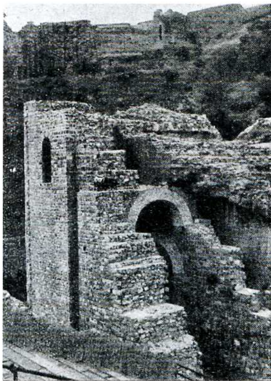
Fig. 3. a —Aspecto de la zona de la fig. 2. a , terminadas las obras de restauración (30/4/59)
